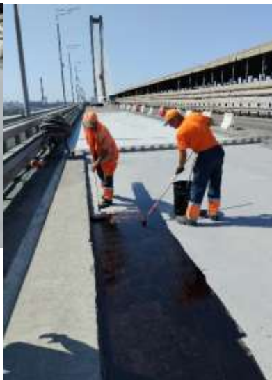
б) нанесення полімерного праймеру
