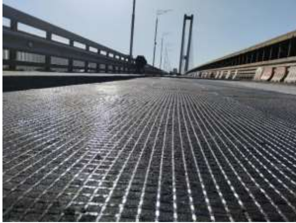
г) укладання гідроізоляційного композитного армуючого матеріалу CompoGrid
