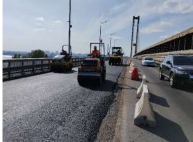
д) укладання та укочення верхнього шару асфальтобетону
