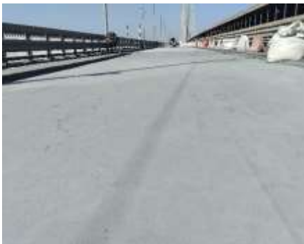
а) підготовка поверхні мостового полотна
